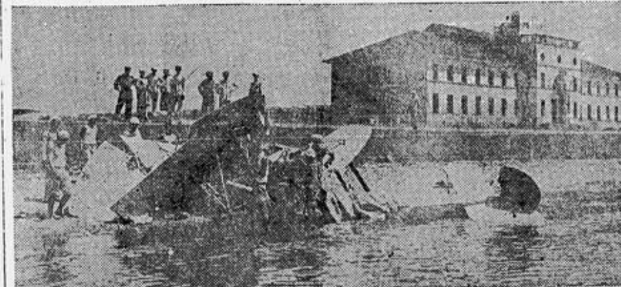
Photographia tirada após o desastre de hontem
